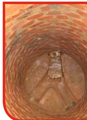
Vor der Handsanierung
